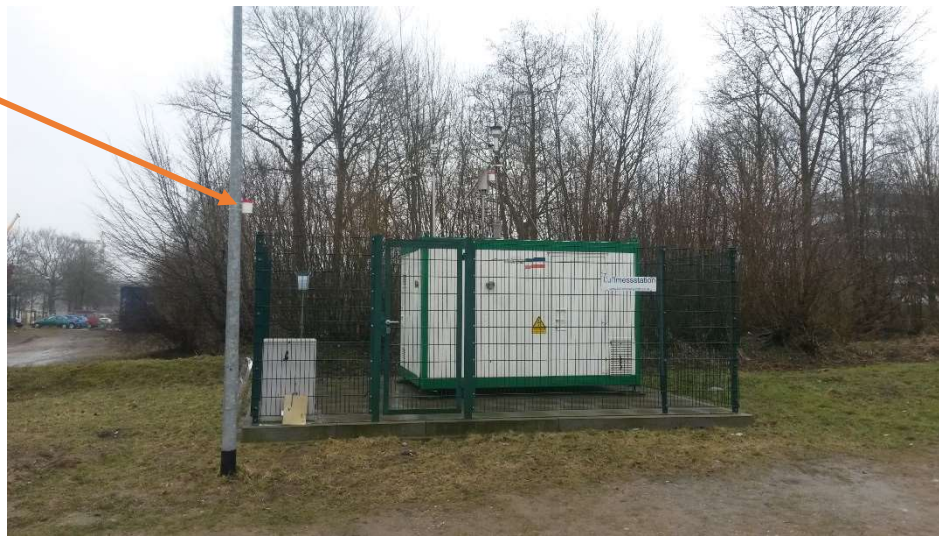
Abbildung 1A. LÜSH Messstation Kiel-Bremerskamp DESH057, Blickrichtung Südost
